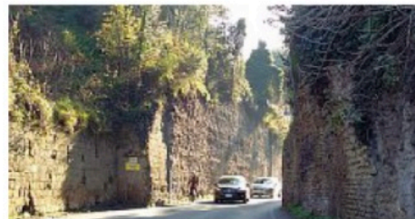
La strada Il taglio che fu realizzato nella collina in età repubblicana
